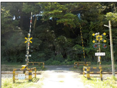
柳沢第3踏切 施工前
