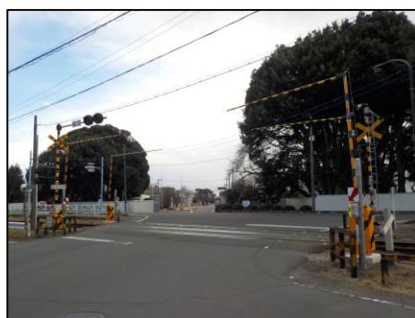
日工前踏切 施工後
