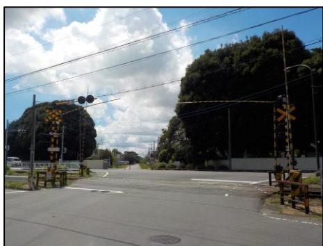
日工前踏切 施工前
