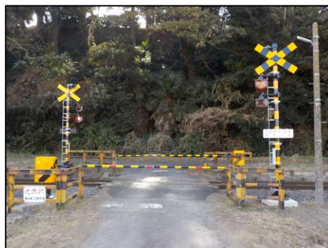
柳沢第3踏切 施工後
