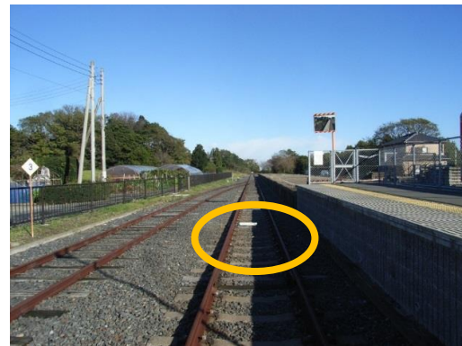
阿字ヶ浦駅終端部 過走防護用 ATS 地上子新設
