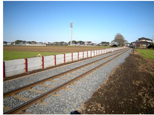
砂塵防護柵設置 (左：設置前 右：設置後)
