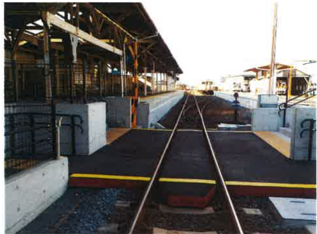
かさ上げされた上りホームと整備された構内通路（左：工事前 右：工事後）
