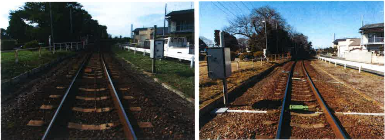
冒進防止用 ATS 地上子の新設（左：工事前 右：工事後）
