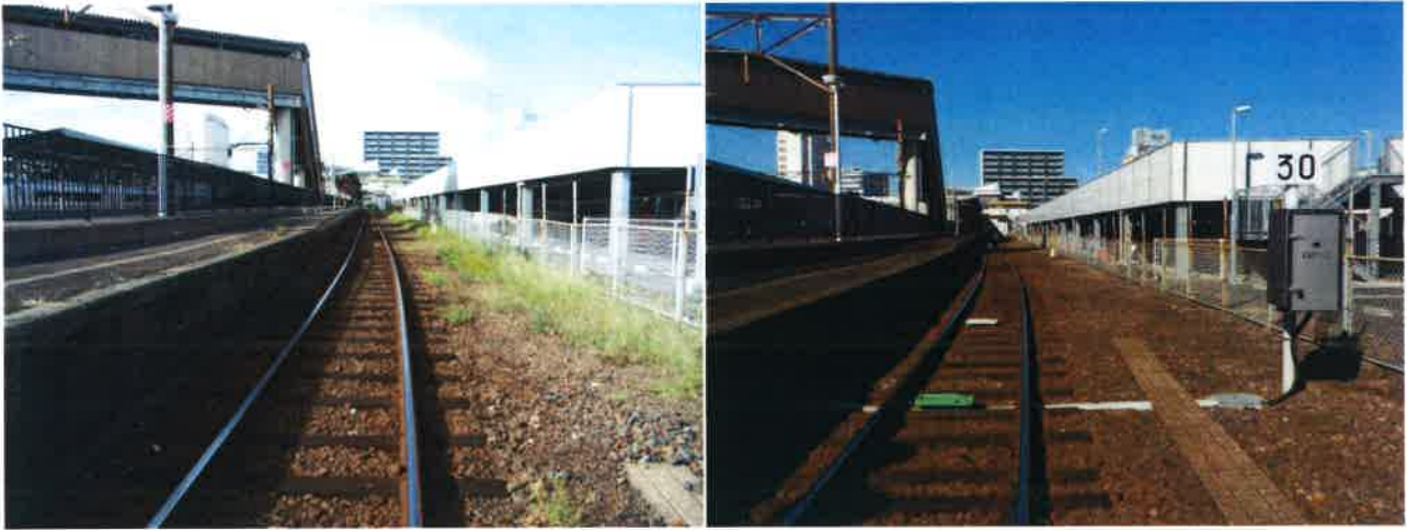
終端防護用 ATS 地上子の新設（左：工事前 右：工事後）
