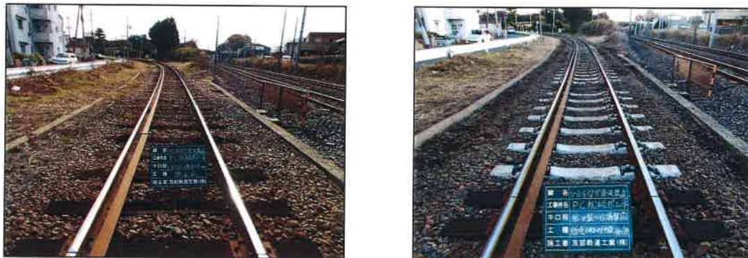
PC 枕木化 (左：交換前 右：交換後)
