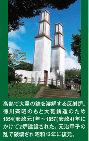
高熱で大量の鉄を溶解する反射炉。徳川齊昭のもと大砲製造のため1854(安政元)年~1857(安政4)年にかけて2炉建設された。元治甲子の乱で破壊され昭和12年に復元。
